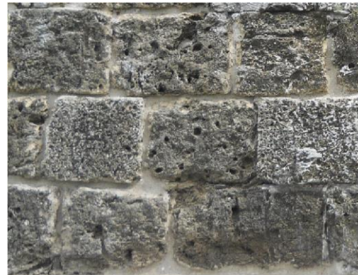
Ilustración 6 Detalle de junta consolidada.
