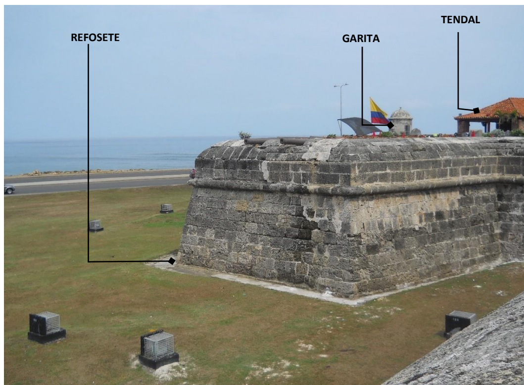
Ilustración 8 Detalle del flanco derecho del Baluarte Santo Domingo.
